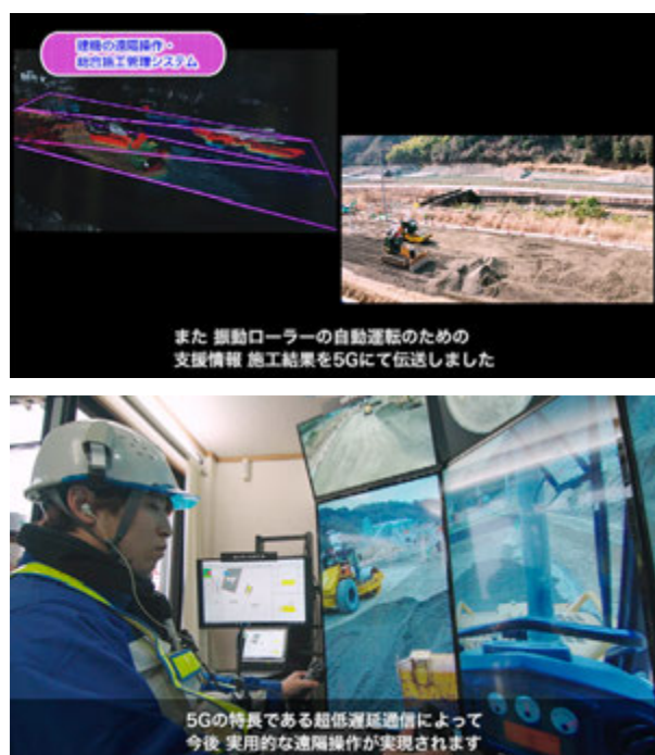
図6 5G総合実証実験における建設重機の遠隔操作の様子
